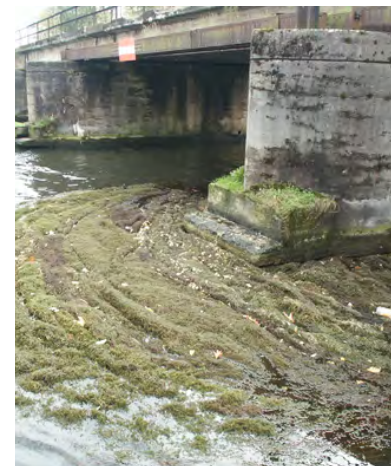
Bild 3: Herbstliches Abtreiben von Elodea nuttallii und Rückstau der Pflanzenmatten vor Brückenpfeilern und der Rechenanlage eines Kraftwerks
