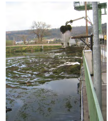
Bild 3: Herbstliches Abtreiben von Elodea nuttallii und Rückstau der Pflanzenmatten vor Brückenpfeilern und der Rechenanlage eines Kraftwerks
